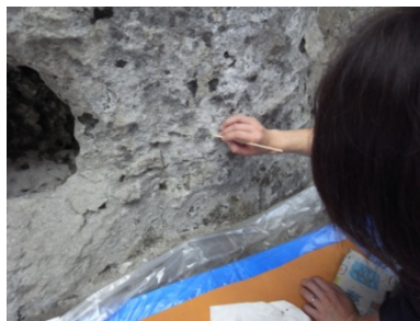
紫外線照射後枯死した着生生物の除去作業の様子
